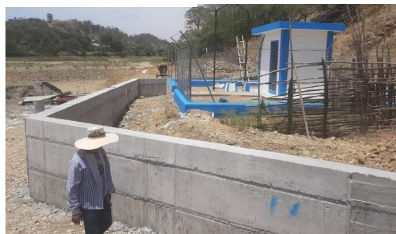
Ilustración 2.37 Muro de protección caseta de bombeo sistema de agua El Oro de Pilares
