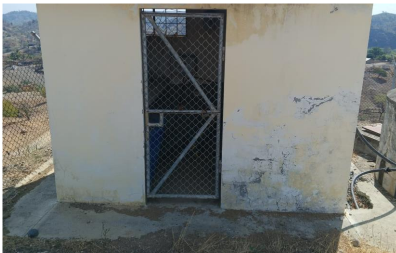
Ilustración 2.38 Estado general de sistema de agua El Mango
