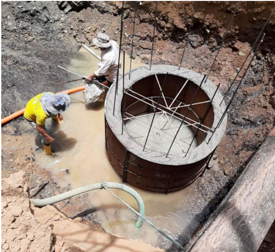
Ilustración 2.98 Construcción de pozos someros en la parroquia Limones
