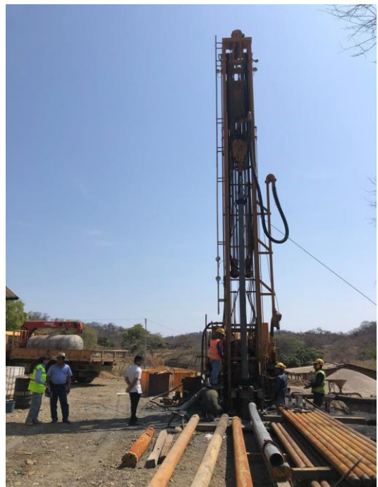
Ilustración 2.41 Prospección física y perforación de pozo profundo para el sistema de agua potable de Malvas – Paletillas de Malvas – Chaquiro
