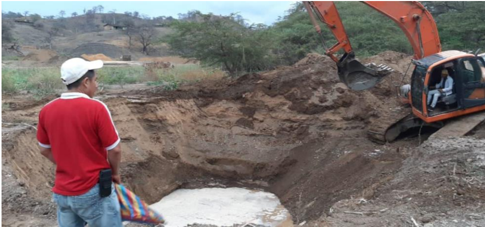
Ilustración 2.97 Excavación de pozos someros en la parroquia Limones
